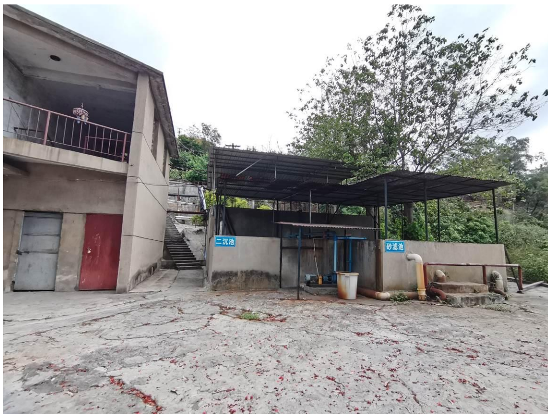
图 3.1-1 现有项目污水处理站现场照片
